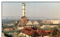
Dans une usine chimique, un mélange de substances toxiques est rejeté à l'atmosphère à la suite de la rupture successive d'un disque et d'une soupape. La soupape n'a pas joué son rôle à cause d'une configuration de montage inadaptée. La pollution n'est découverte que 9 h plus tard, aucun dispositif ne permettant d'informer les opérateurs de l'ouverture des soupapes. Une pellicule de poussière jaune recouvre 3 ha de terrains.
